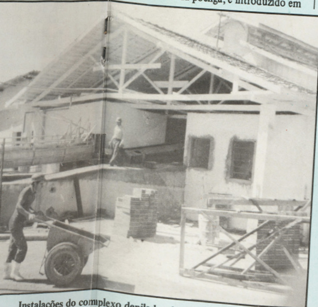
Instalações do complexo depilador de suínos
