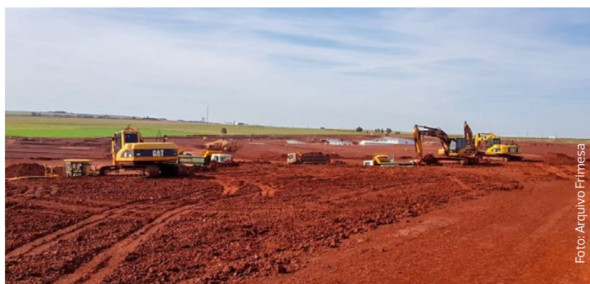
VANZELLA e conselho fiscal acompanhando o andamento das obras em Assis.
